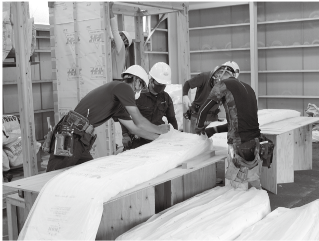
断熱材の加工(下関会場)
