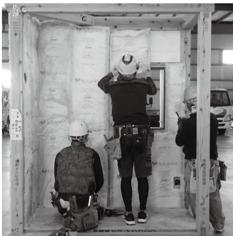
断熱材の施工(防府)
