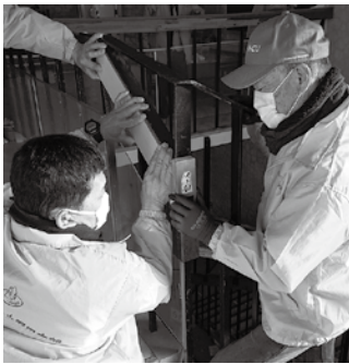
階段の手すり取り付け作業
