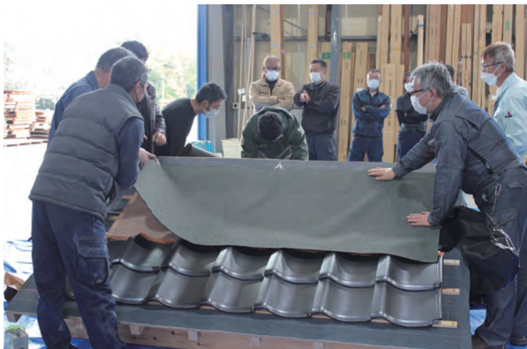
受講者も実際に施工方法を確認
