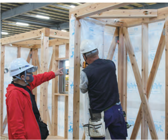
講師の指導のもと断熱施工
