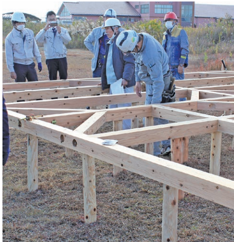
木杭基礎上に土台敷き
