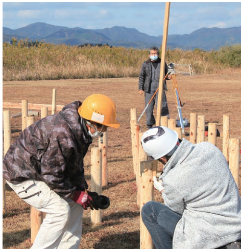
木杭のレベル出し
