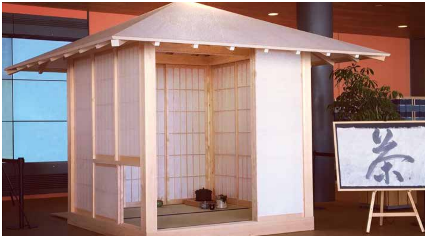
イベント用に木造組み立て式で製作された二畳茶室
