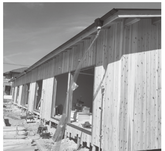
被災者のため急ピッチで作業が進められた
