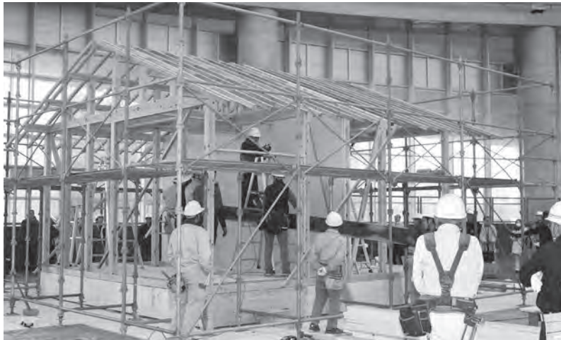
9坪モデルの木造応急仮設住宅
