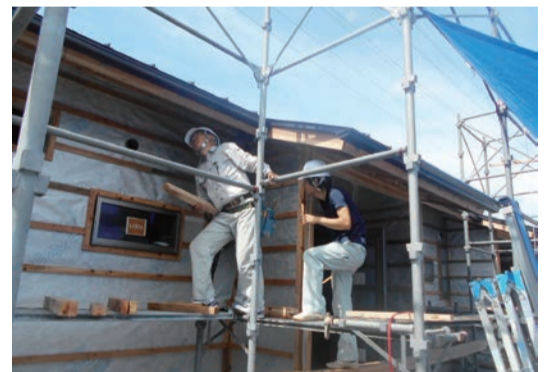
熊本の応急仮設現場に参加する建設山口の仲間
