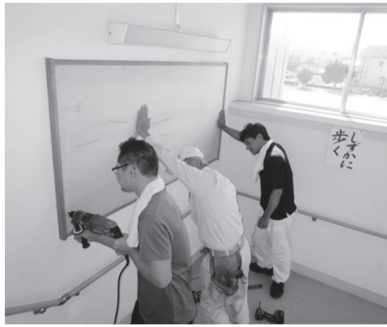
掲示板を設置する仲間
