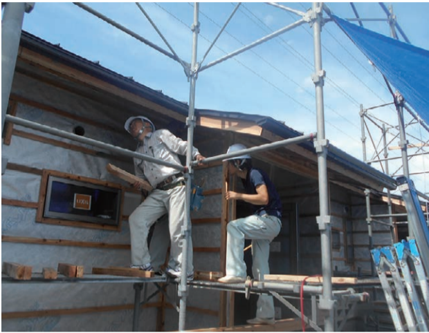
建設山口の仲間も仮設現場を体験（7/30熊本）
