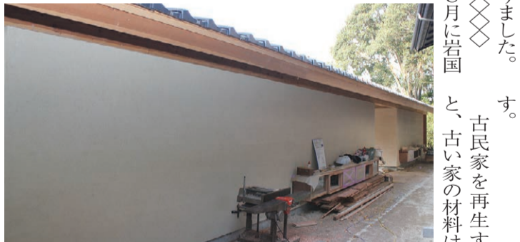
壁は石灰を混ぜた土壁。自然にこだわる。
