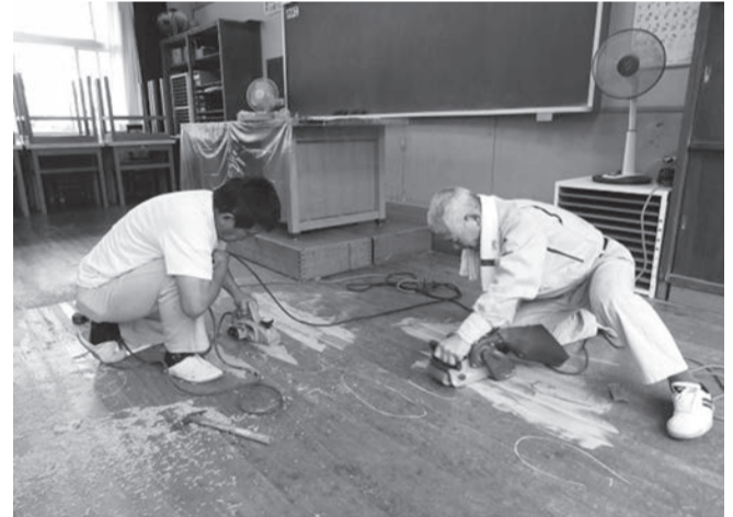
慣れた手つきで床修理
