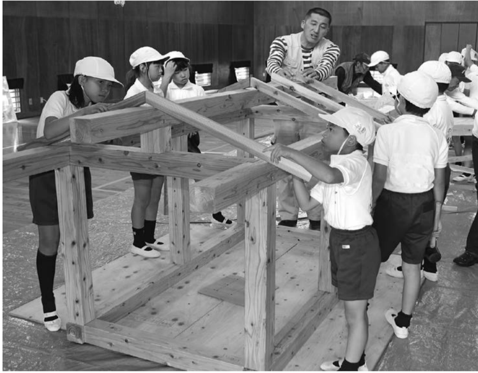
大工さんと一緒に自分たちの手で木組みを完成させたよ
